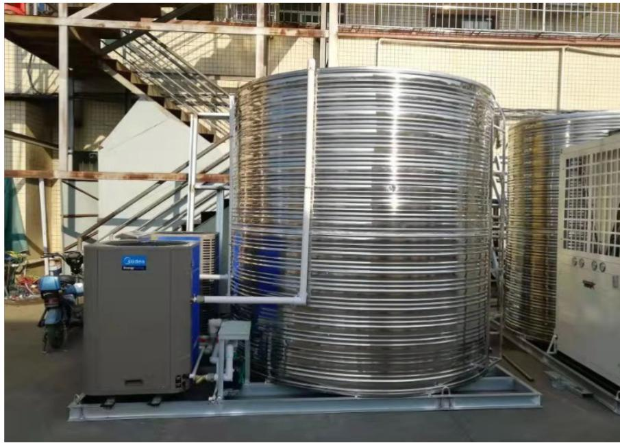
空气能一体机热水器的设备性能稳定，使用寿命在10-15年左右。超长的使用寿命，部分的抵消了空气能热水器造价较贵的缺点。看完优点，也来看看缺点：缺点1、温差依赖性较大这是空气能比较大的缺点。跟空调类似，空气能热水器在冬天温度特别低的时候，使用会受到一定限制。冬天的制热时间会更长，如果温度过低，还会启动困难。空气能热水器的正常工作温度在-7℃到48℃之间，后面由于喷气增焓技术的出现，比较低能到-25℃也可以使用，不过需要使用电辅热功能，会消耗额外的电能。所以空气能热水器比较好用的地方还是南方，往东北、西北走的北部地区，相对来说没那么好用，添加电辅热后，相对燃气，节约的钱就没那么多了。中部比如华北、陕西、山东等地区，冬天低于-7度的时间也不多，启用电辅热的机会少，也是可以选择空气能一体机的。
