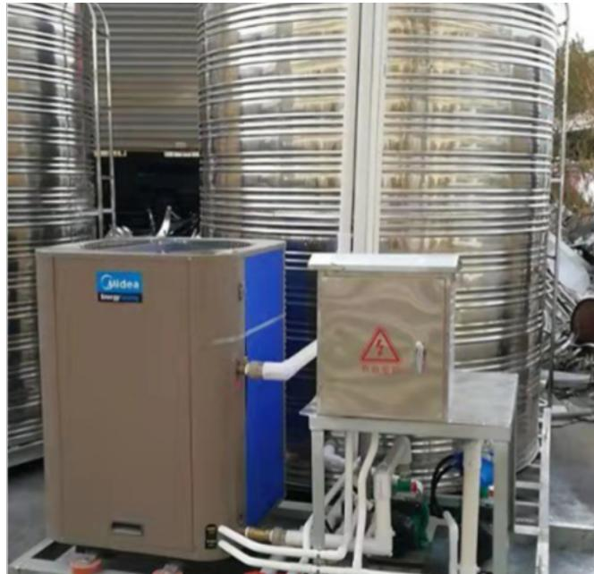
一般就是指我们设定的水温温度较高。例如水温设置在了70℃，在这种情况下，我们用掉一部分热水以后就开始补水。但是补水以后的热水水温仍然是较高的，基本上会达到50℃以上。这样就会导致空气能热泵的热水机组一直处在高温度下工作，导致效率下降的很厉害，增加了耗电量。④：水箱或者是管道保温不符合要求，导致耗电量严重增加。因为空气能热水器所产生的热水都要储存的水箱中，而我们在使用的时候，就是通过管路从水箱中把水输送到我们的室内。所以说，在这个过程中，热水如果保温效果不好，就与外界交换热量。特别是在冬季的时候，热量散失的很快。就导致空气能热水器需要重新去加热热水，时是耗电量也是很大。⑤：另外还有一点，就是现在很多朋友家里安装了循环水，也就是我们所说的循环热水，或者是带有回水系统的热水。无论是循环热水或者是回水系统，在持续循环的过程中，循环泵首先会增加耗电量，另外热水在循环的过程中，
