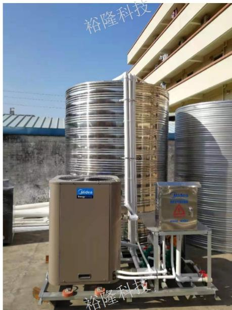
现在已经成为消费者选购家电时的一大参考指标。在热水器领域，说到节能就不得不提起空气能热水器，对于这个市场新贵，相信大家都略有耳闻，知道它十分节能，号称一度电当四度用，节能效率高达75%。那么空气能热水器究竟有多节能？和传统的燃气、电热水器相比有何优劣势？现在我们就来聊聊空气能热水器。“烧空气”的热水器大家应该都很好奇，空气能热水器究竟是靠什么能量来加热水的，难道是真的“烧空气”吗？其实空气能热水器并不是“烧空气”，但它确确实实是用空气来制热的，它利用的就是空气中的热能。空气能热水器，也称“空气源热泵热水器”。空气能热水器把空气中的低温热量吸收进来，经过氟介质气化，然后通过压缩机压缩后增压升温，再通过换热器转化给水加热，压缩后的高温热能以此来加热水温。
